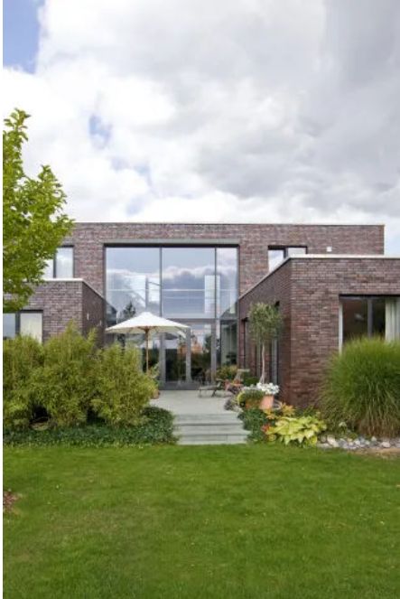
Wittmunder Klinker Sortierung 11 - Haus BW, Braunschweig, O.M. Architekten BDA
