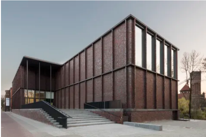
Wittmunder Klinker Sortierung 191D - Neues Museum, Lüneburg (© Heidenreich & Springer Architekten)
