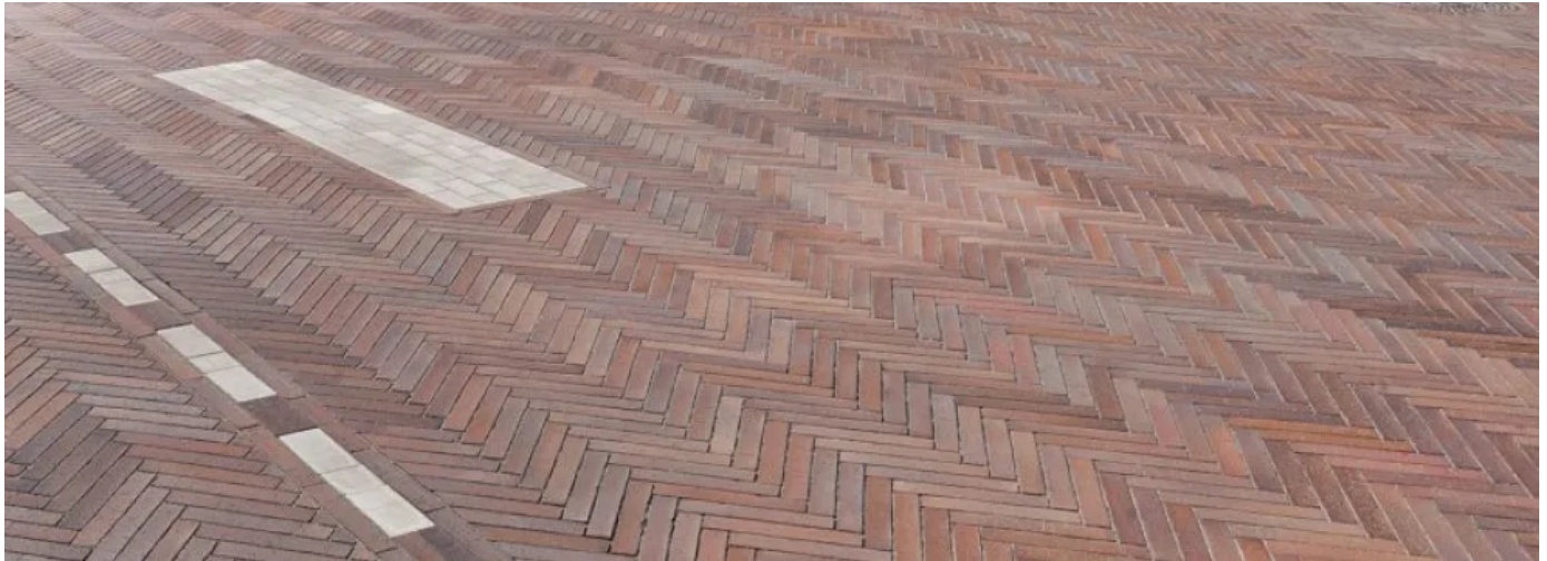
Klinker-Riegelformat 320 x 52 x 115 mm; ©Anke Müllerklein
