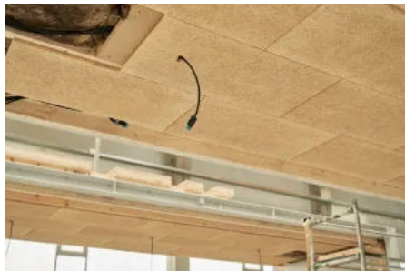
Vorgefertigtes Deckenelement mit Abhangdecke und Elektroinstallation
