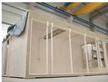
Industrielle Vorfertigung inklusive Elektroinstallationen
