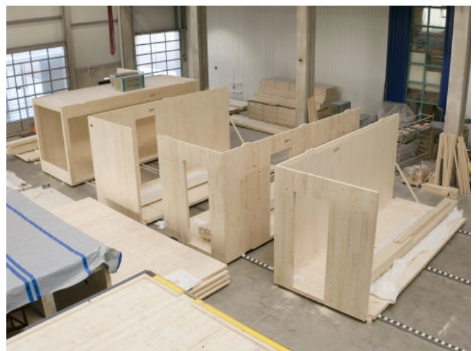
Entstehung der Holzmodule aus einzelnen Brettschichtholztafeln
