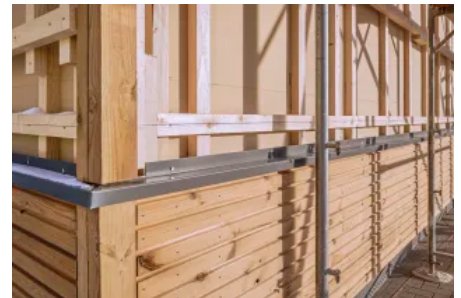
Individuelle Fassade als Vorhangkonstruktion
