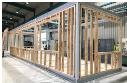
Holz-Hybrid-Modulbauweise von KLEUSBERG
