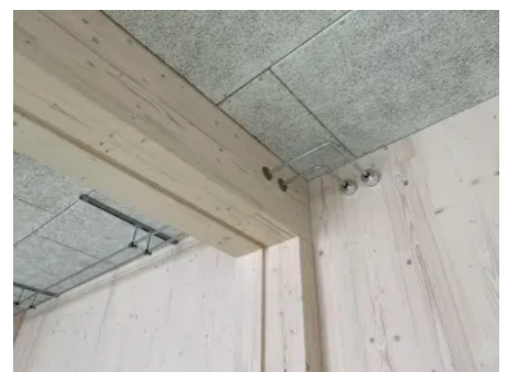
Querträger mit Akustikdecke und bewusst sichtbaren Rohrleitungen
