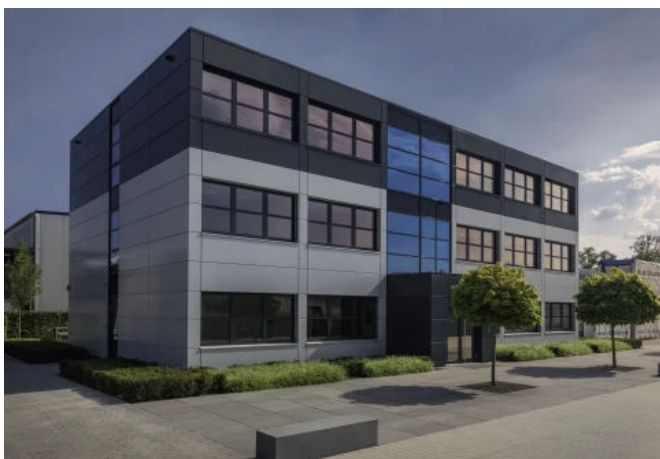
Aufstockung Bürogebäude KLEUSBERG, Remseck
