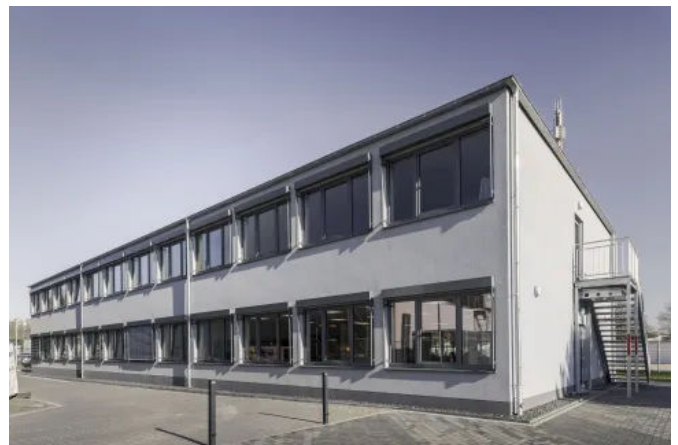
Sozialgebäude ModuLine® können mit einer Putz-, Metall-Kassetten- oder Holzfassade versehen werden. (© Rüdiger Mosler)
