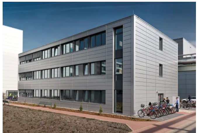
Moduline® Gebäude können mit einer Putz-, Metall-Kassetten- oder Holzfassade versehen werden. (© Rüdiger Mosler)
