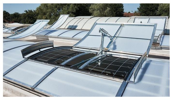
Rauch- und Wärmeabzugsgeräte (RWG) in Lichtkuppeln mit einem mindestens 30 cm hohen Aufsetzkranz, müssen gemäß europäischer Richtlinien eine aerodynamisch freie Öffnung freigeben. Hierzu wird die Lichtkuppel über ein Aufstellaggregat auf ca. 165° geöffnet. Bei Sanierungen von Dächern und Nutzungsänderungen von Gebäuden können RWG in Sanierungsaufsetzkränze eingebaut werden. Auch in Lichtbänder und hier im Speziellen in integrierte Klappen können RWG eingesetzt werden.
