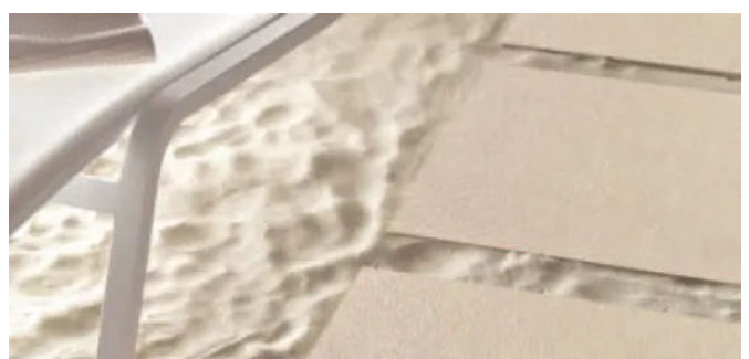
Verlegung im Sand
