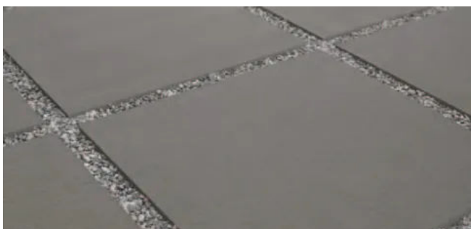
Verlegung im Kies
