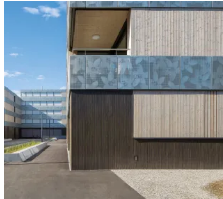
Wohn- und Geschäftshauskomplex „Flor“, Uster, Schweiz / Architekt: Burckhardt+Partner AG, Zürich, Schweiz
