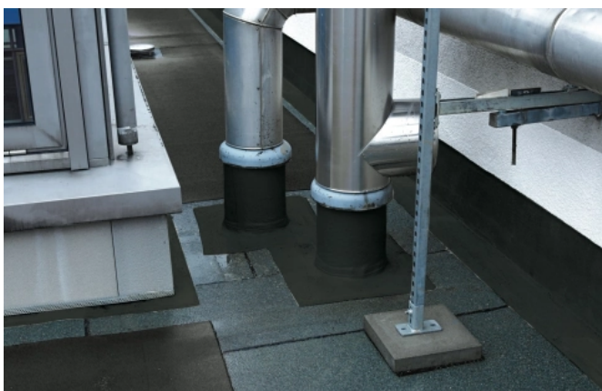
Die einkomponentige, lösemittelfreie Flüssigabdichtung ist besonders für Anschlüsse und Details auf Kombidächern geeignet.
