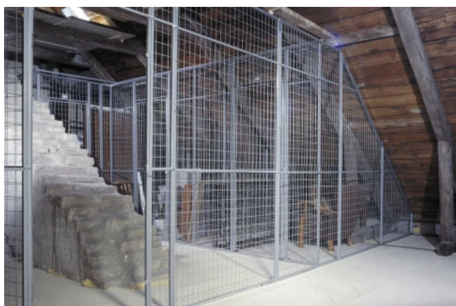
Troax Classic im Dachraum
