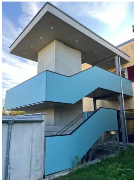
Kombination Aufzugsschacht mit Treppenaufgang in Fürstenfeldbruck
