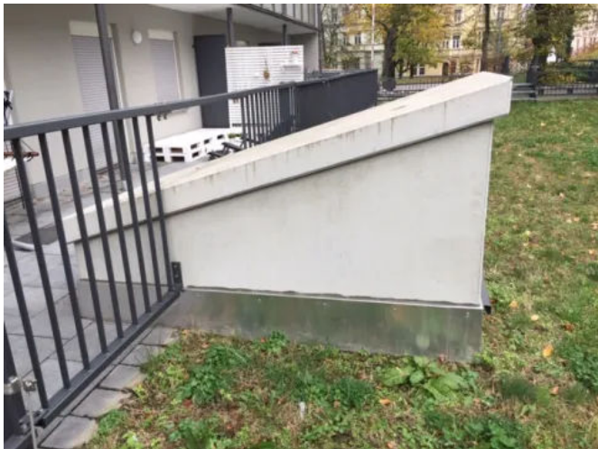
Ausführungsbeispiel HIEBER Lüftungsschacht mit individuell gestalteter Abdeckung
