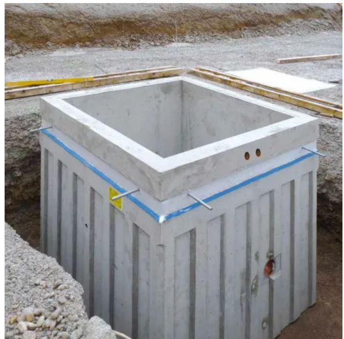
HIEBER Pumpensumpfschacht Typ SA mit sichtbarer Anschlussbewehrung
