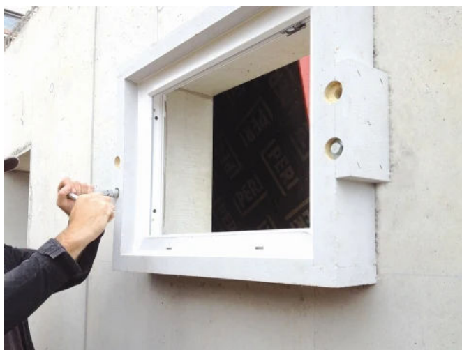
Kellerfenster-System CombiTherm - Baustelle
