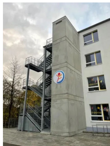
Aufzugsschacht an einer integrativen Schule in Lauingen
