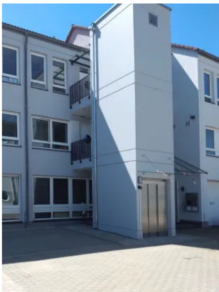
Aufzugsschacht an Verwaltungsgebäude in Friedberg
