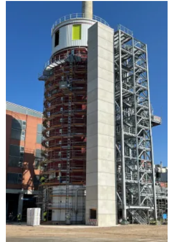
Aufzugsschacht über 8 Geschosse in Uelzen
