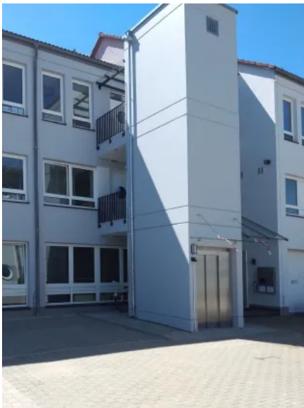
Aufzugsschacht an Verwaltungsgebäude in Friedberg
