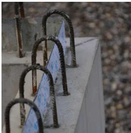
Fugenblech und Anschlussbewehrung beim Pumpensumpfschacht Typ Standard
