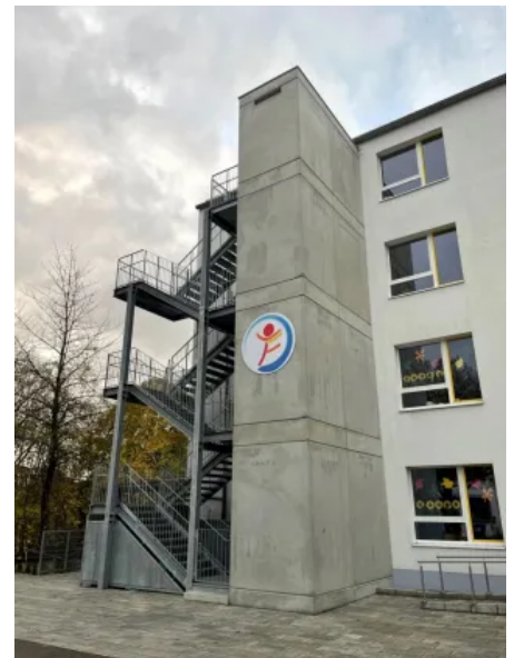
Aufzugsschacht an einer integrativen Schule in Lauingen
