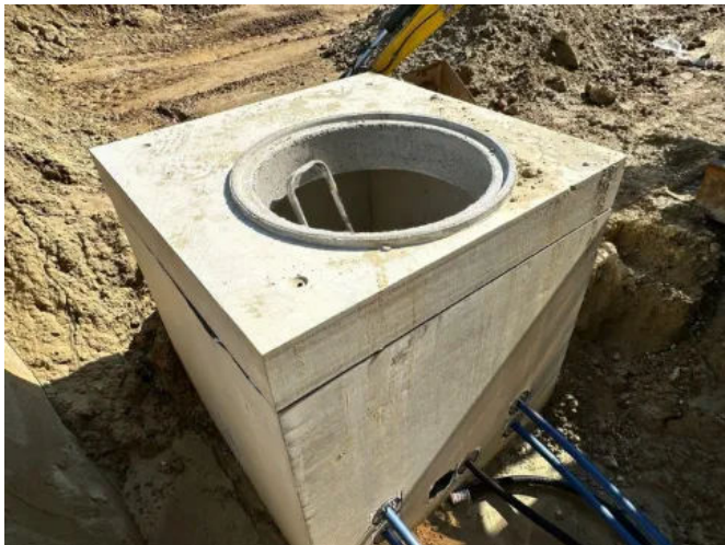
Ausführungsbeispiel HIEBER Kabelzugschacht mit Installationen
