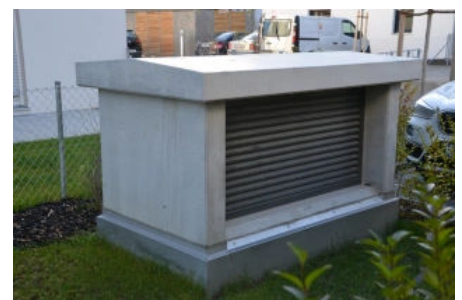
Lüftungsschacht als Betonfertigteile
