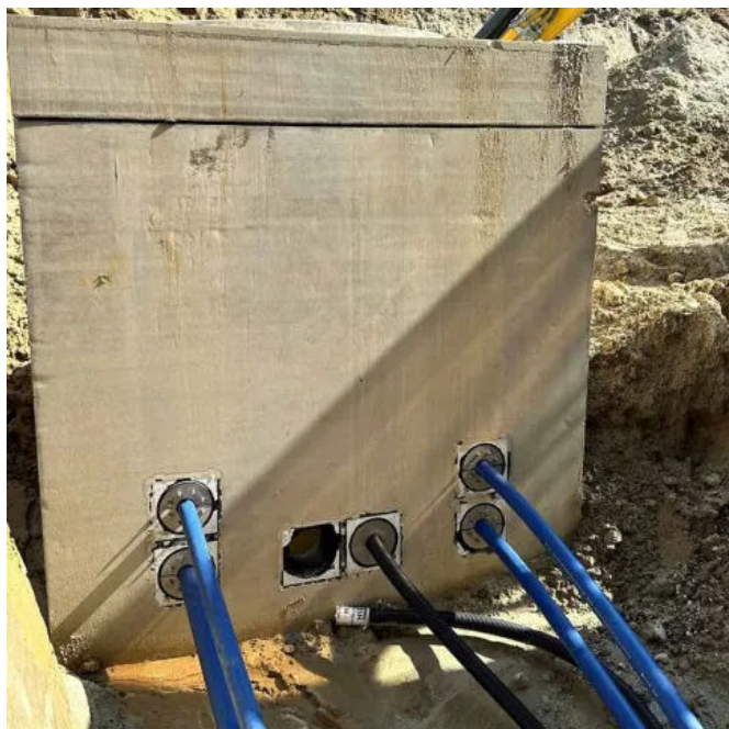
Einsatz der Fertigfundamente im Solarpark Wörleschwang
