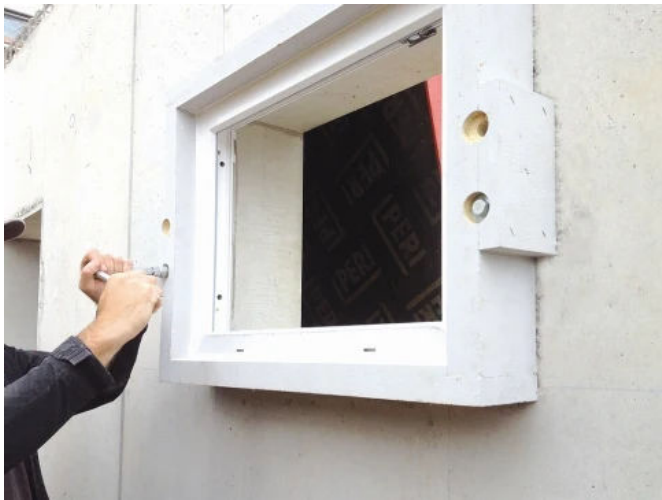
Kellerfenster-System CombiTherm - Baustelle
