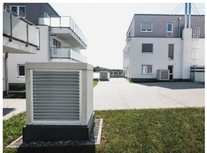
Lüftungsschachteinhausung in Sichtbetonqualität
