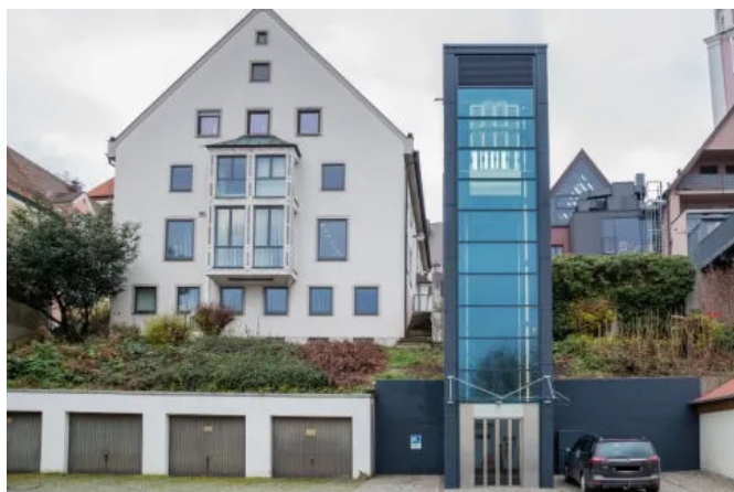
HIEBER® Aufzugsschachtelemente sind für Neubauten und nachträglichen Anbau von Aufzügen einsetzbar.
