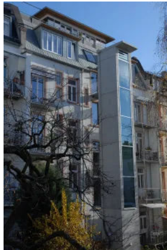
Wohnhaus mit Aufzug in Frankfurt
