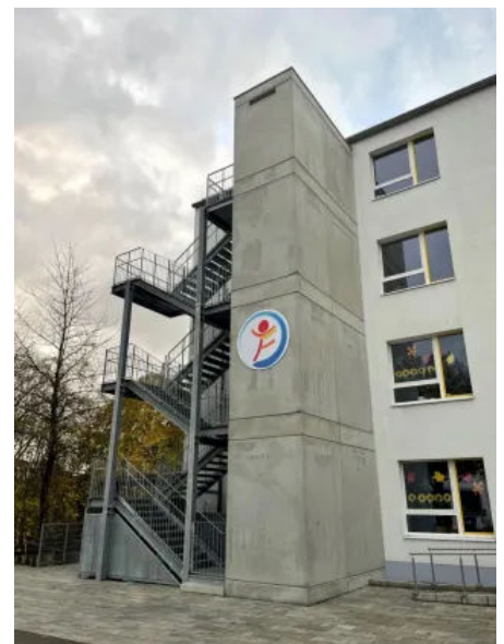
Aufzugsschacht an einer integrativen Schule in Lauingen
