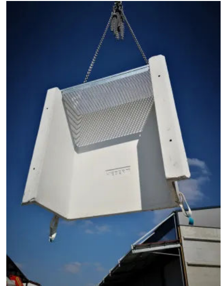
Lichtschacht Optimus aus weißem GFB
