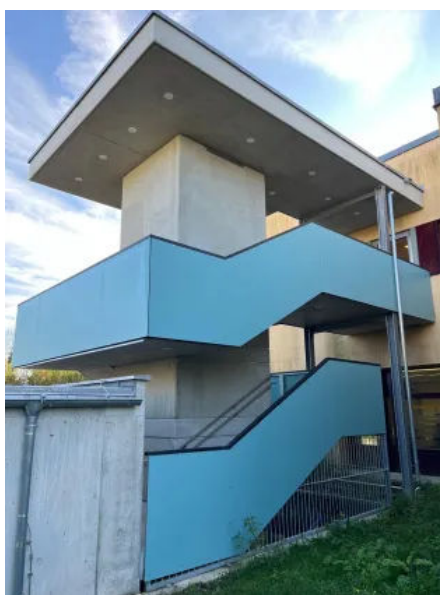
Kombination Aufzugsschacht mit Treppenaufgang in Fürstenfeldbruck
