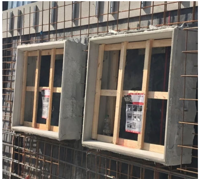
Kellerfenster-System Solitär Thermo-Baustelle
