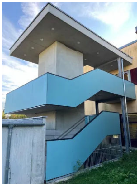
Kombination Aufzugsschacht mit Treppenaufgang in Fürstenfeldbruck
