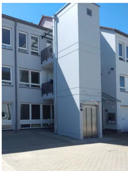
Aufzugsschacht an Verwaltungsgebäude in Friedberg
