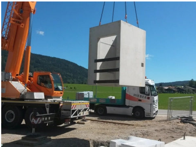
Die geschosshohen Elemente werden Just-in-Time angeliefert.
