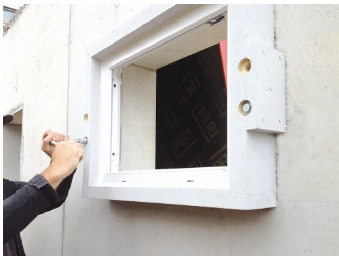
Kellerfenster-System CombiTherm - Baustelle
