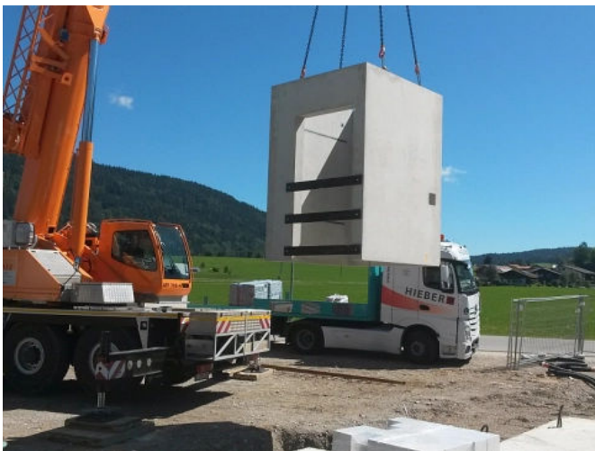
Die geschosshohen Elemente werden Just-in-Time angeliefert.
