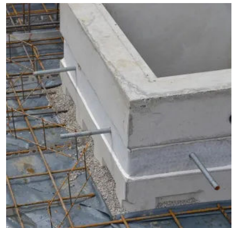
Anschlussbewehrung beim Pumpensumpfschacht Typ SA
