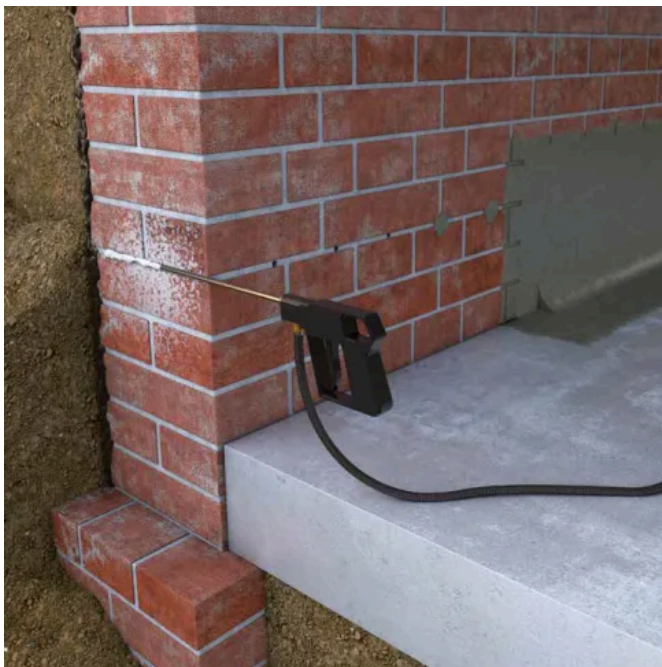
Das creme-Verfahren ohne Hohlraumverfüllung (© Remmers)
