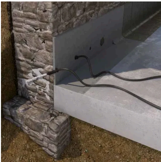
Das advanced-Verfahren mit Hohlraumverfüllung (© Remmers)
