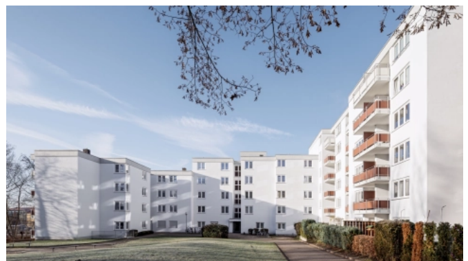
Bayreuth, Wohnanlage Wilhelm-von-Diez Straße
