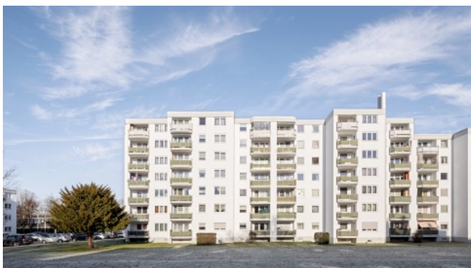
Bayreuth, Wohnanlage Wilhelm-von-Diez Straße
