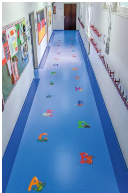
Sanierter und neugestalteter Boden mit Motiven
