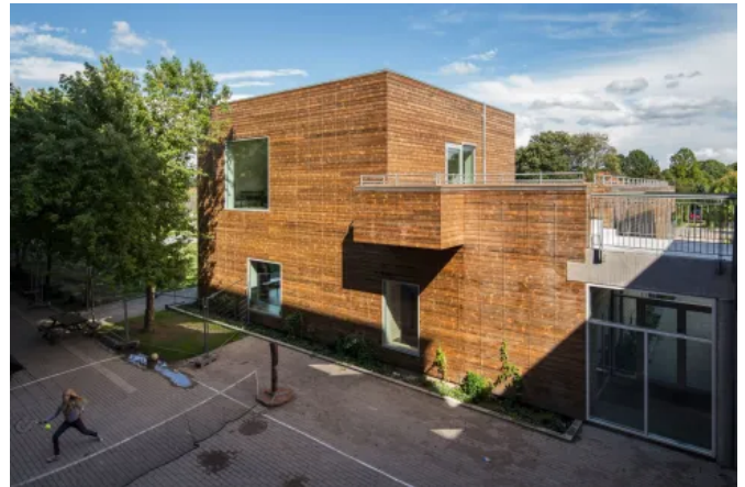
Schule in Gentofte, Dänemark; Architekt: Arkitema Architects; Foto: © Niels Nygaard
