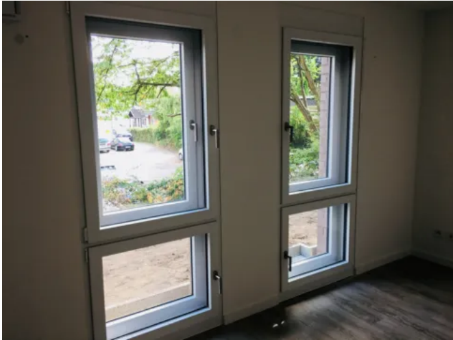
Bodentiefe Kastenfenster mit Brüstungsriegel
