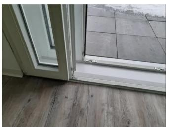
Barrierefrei: Kastenfenster als Balkontür mit 20 mm Flachschwelle
