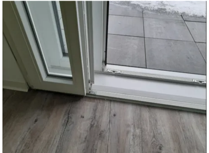
Barrierefrei: Kastenfenster als Balkontür mit 20 mm Flachschwelle
