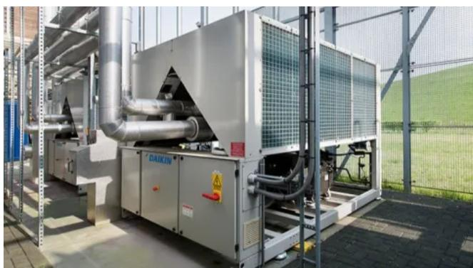
Die mit modernster Wärmepumpen- und Invertertechnologie, optional auch mit Wärmerückgewinnung, ausgestatteten Daikin Kaltwassersätze zeichnen sich durch ein optimales Betriebsverhalten und einen effizienten Energieverbrauch aus. Dies ermöglicht niedrigere Betriebskosten und eine verbesserte CO<sub>2</sub>-Bilanz.
