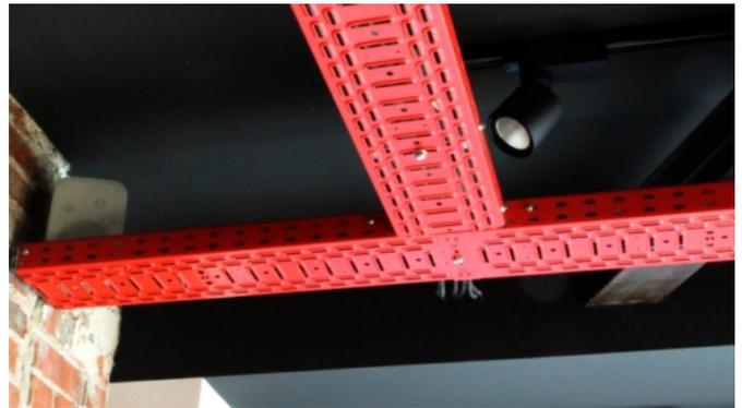
OBO Kabelrinnen sind in allen RAL-Tönen pulverbeschichtet erhältlich
