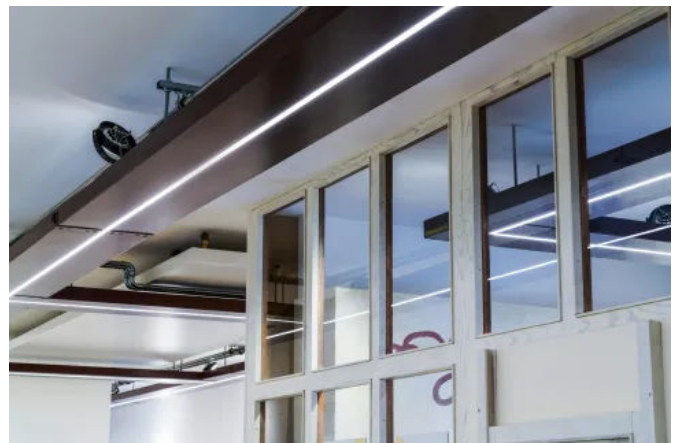
Ungelochte Kabelrinnen mit LED-Modul setzen Akzente.
