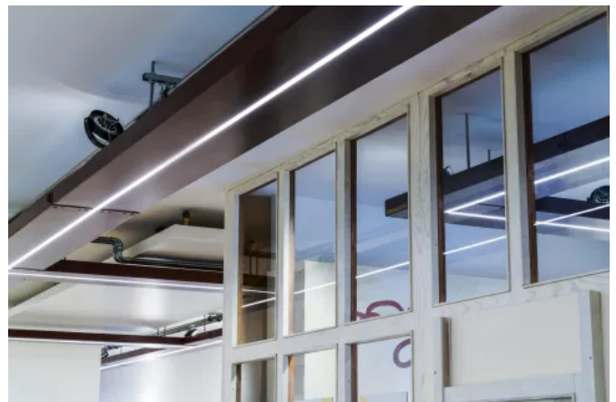
Ungelochte Kabelrinnen mit LED-Modul setzen Akzente.
