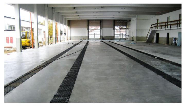
Der Versorgungskanal bietet Flexibilität bei der Verlegung von Kabeln, Rohren und Leitungen für schwerlastbefahrbare Bereiche In Produktions- und Messehallen, an öffentlichen Gebäuden sowie im Innen- und Außenbereich. Die Basis bilden verschiedene Nennweiten und individuelle Ausstattung mit Schienen und Trägern, die auch Sonderlösungen bei der Planung ermöglichen.
