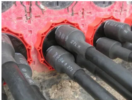
Systemdeckel HSI150 D KS für Kabelabdichtung in Kaltschrumpftechnik.
