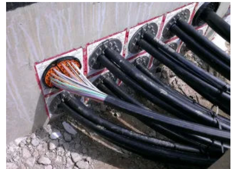
Eine schonende Abdichtung von Steuerleitungen oder Mikrokabeln kann durch Segmenteinsätze realisiert werden.
