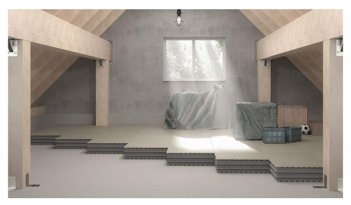
Ob eine gesamte Dachdämmung notwendig ist, hängt davon ab, ob das Dachgeschoss auch als Wohn- und Lebensraum genutzt wird. Falls nicht reicht es aus eine Dämmung der obersten Geschossdecke vorzunehmen. Diese Art der Dachisolierung spart Heizkosten ein, das Dachgeschoss bleibt als Stauraum nutzbar und die darunterliegenden Wohnräume profitieren von einer deutlichen Verbesserung des Raumklimas.
