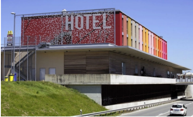
Vorgehängte Webnet-Fassade, Estavayer-le-Lac (CH)
