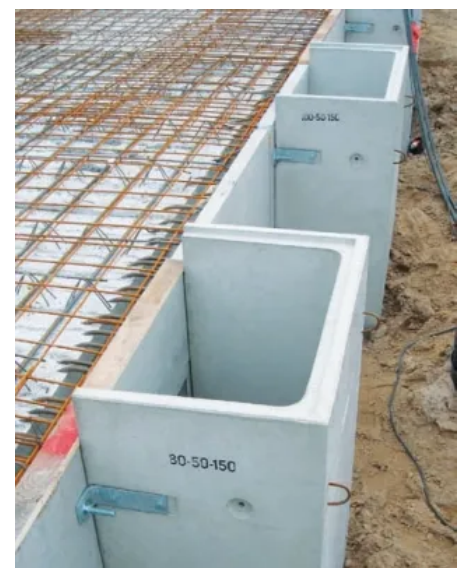
Anschraub-Lichtschacht ohne Dämmung
