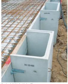
Anschraub-Lichtschacht ohne Dämmung
