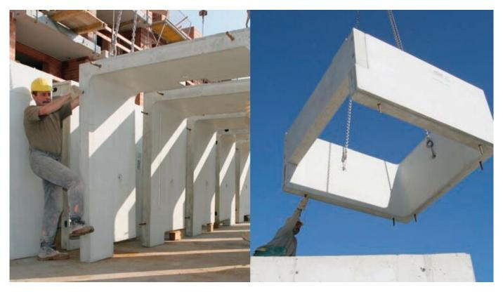
Betonfertigteilschächte SAS werden auf Maß gefertigt und als Lichtschächte, Lüftungsschächte, Revisionsschächte, Versorgungsschächte bzw. Ausstiegsschächte eingesetzt. Varianten als wasserundurchlässige Lichtschächte, Aufzugschächte, Winkelschächte, Pumpensumpfschächte oder Schächte mit Ausschnitt, auch für mehrgeschossigen Aufbau.
