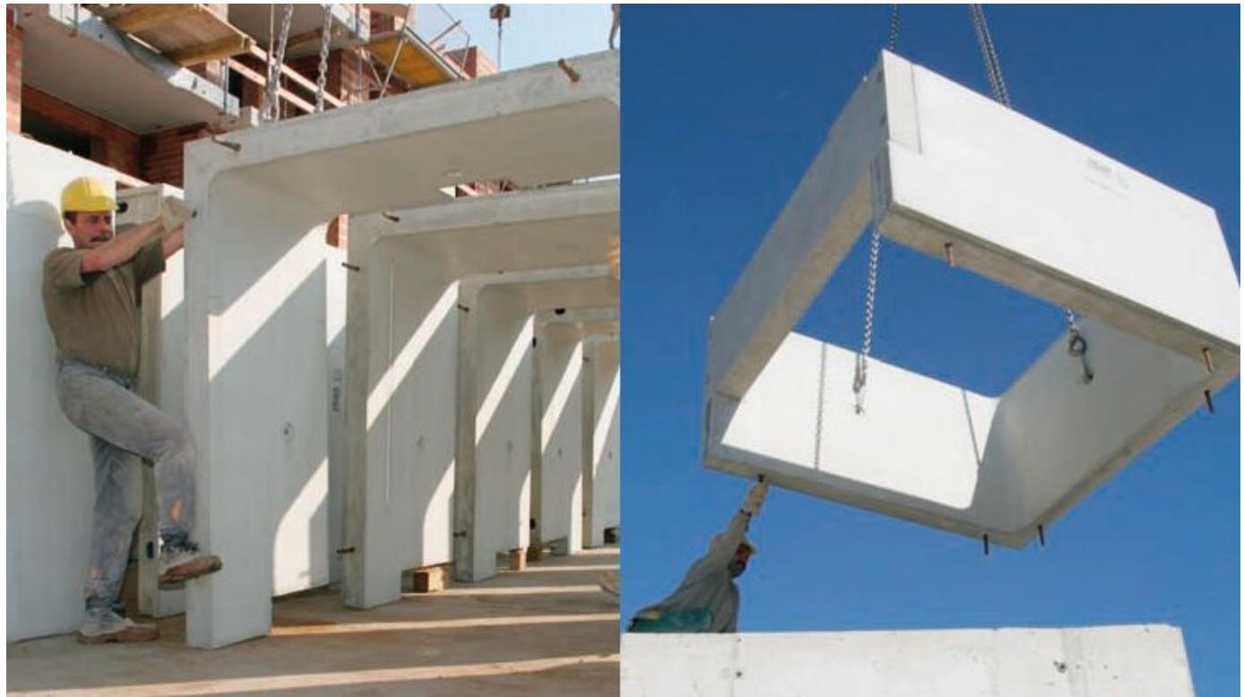
Betonfertigteilschächte SAS werden auf Maß gefertigt und als Lichtschächte, Lüftungsschächte, Revisionsschächte, Versorgungsschächte bzw. Ausstiegsschächte eingesetzt. Varianten als wasserundurchlässige Lichtschächte, Aufzugschächte, Winkelschächte, Pumpensumpfschächte oder Schächte mit Ausschnitt, auch für mehrgeschossigen Aufbau.
