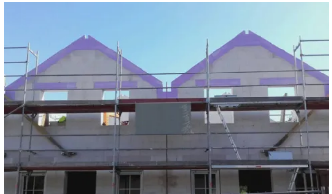
Wärmebrückendämmung - Giebelschalung
