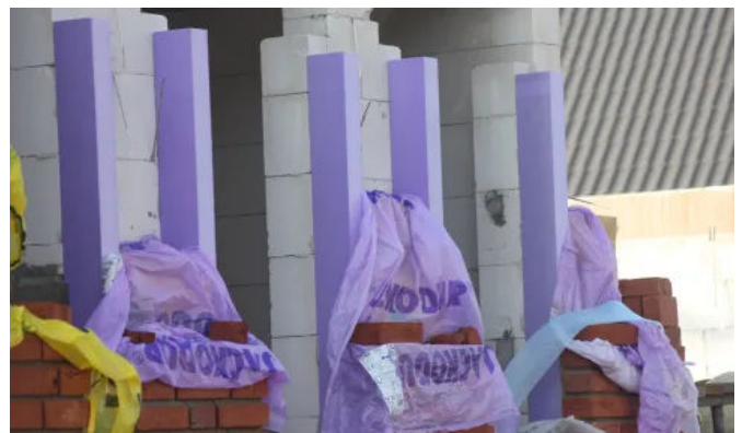
Wärmebrückendämmung - Mauerrandstreifen
