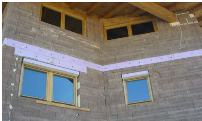
Wärmebrückendämmung - Deckenrandschalung
