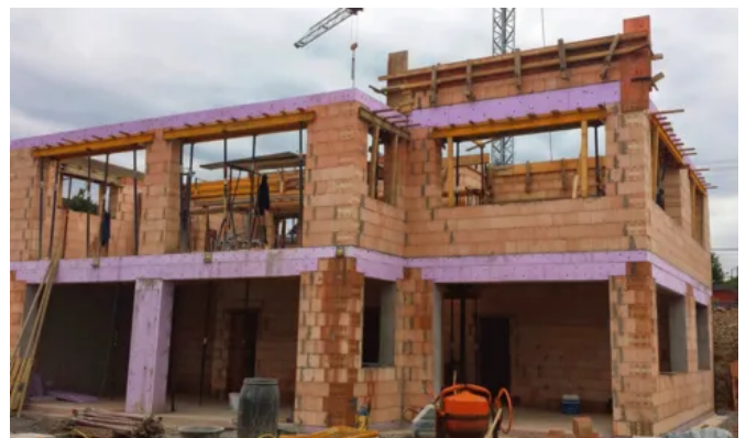
Wärmebrückendämmung
