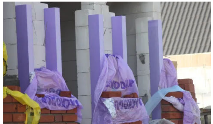
Wärmebrückendämmung - Mauerrandstreifen
