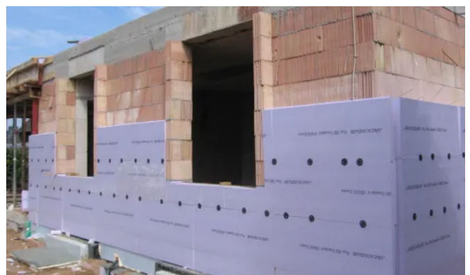
JACKODUR® Wärmedämmung - Beispielanwendung: Kerndämmung
