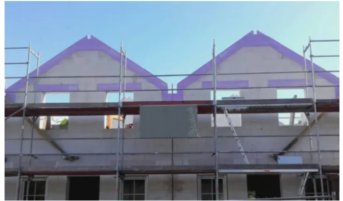
Wärmebrückendämmung - Giebelschalung
