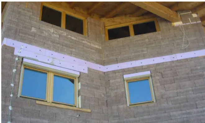
Wärmebrückendämmung - Deckenrandschalung
