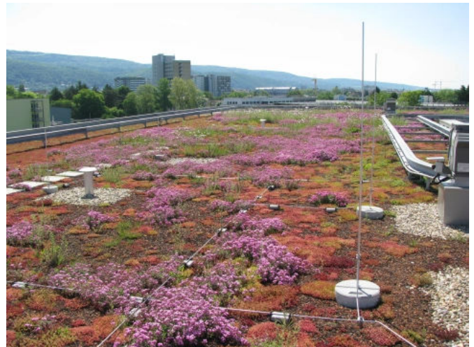
Umkehrdachdämmung begrünt
