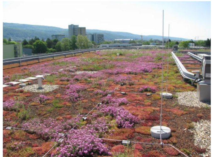
Umkehrdachdämmung begrünt
