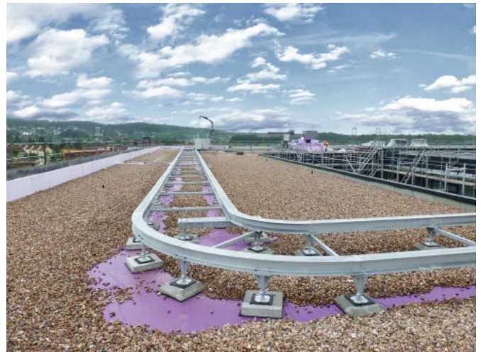
Umkehrdachdämmung bekiest
