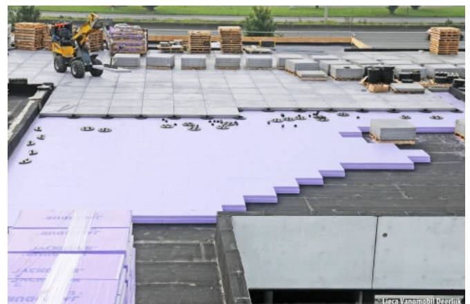
Umkehrdachdämmung befahrbar
