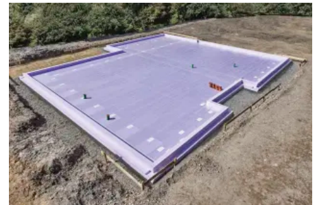
JACKODUR® Atlas: Ein Ausschalen oder das seitliche Sichern des Perimeter-Dämmsystems ist nicht erforderlich.
