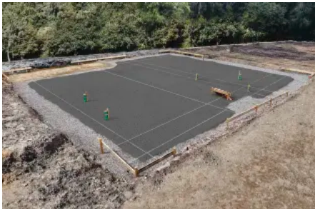
Bodenplattendämmung mit JACKODUR® Atlas
