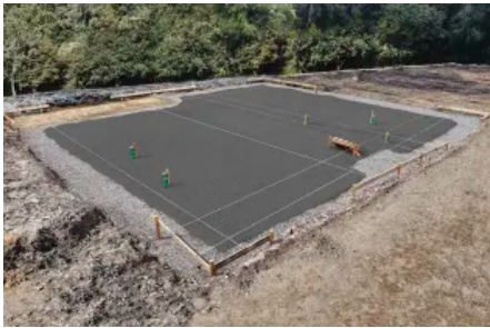
Bodenplattendämmung mit JACKODUR® Atlas
