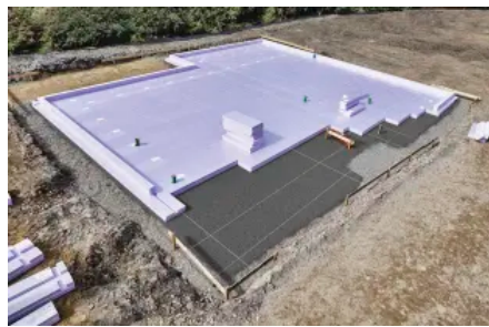
JACKODUR® Atlas: Das Dämmen und Schalen der Bodenplatte erfolgt in einem Schritt.
