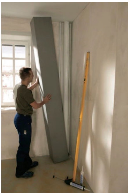
Rohrverkleidung mit JACKOBOARD® Canto
