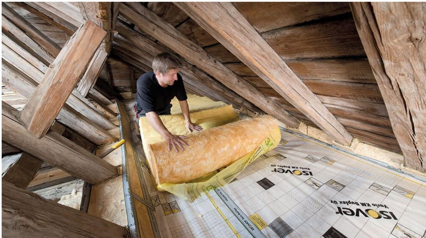
Nichtbrennbare Dämmfilze aus Glaswolle und -platten aus Steinwolle zur nachträglichen Dämmung der obersten Geschossdecke mit hervorragenden Wärme-, Brand- und Schallschutzeigenschaften.
