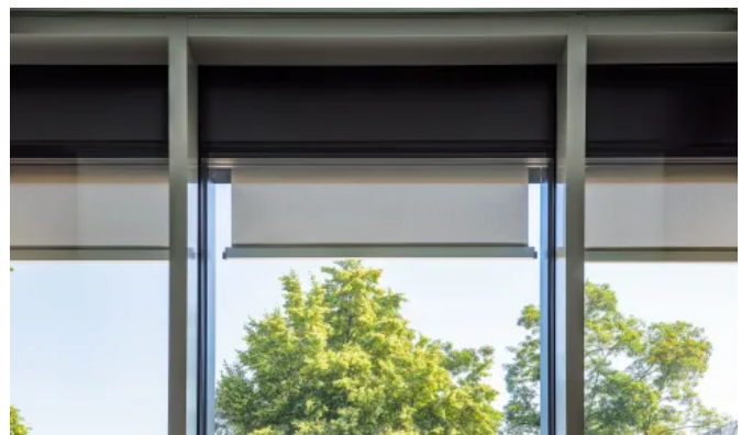
Die Fassadenelemente wurden mit einer integrierten Senkrechtmarkise ausgeführt. (© Till Schuster)
