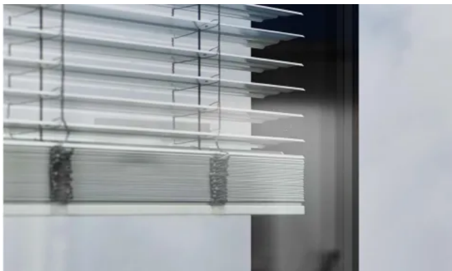
Raffstores mit Lichtlenklamellen sorgen für optimalen Lichteintrag. © BECKER LACOUR / Olaf Becker
