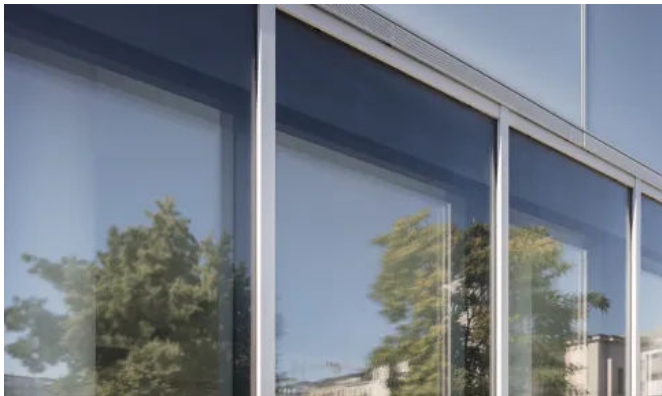
Die Sonnenschutzanlage befindet sich geschützt im Scheibenzwischenraum. © Till Schuster
