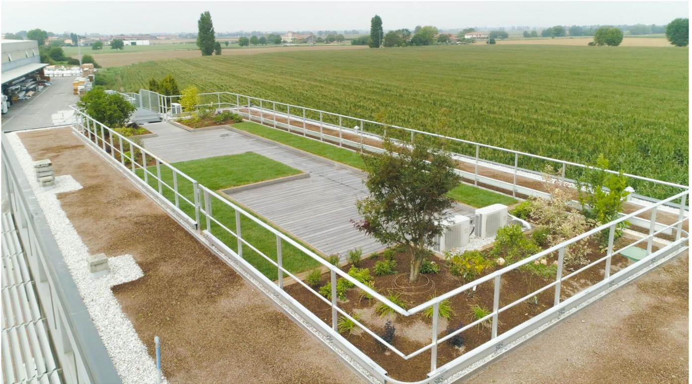
GreenROOF wird auf den Isodeck PVSteel-Paneelen installiert, die als Basis für Flachdächer verwendet werden. Das Außenblech ist mit einer schützenden, wurzel- und wasserfesten Kunststoffolie aus PVC (mit FLL-Zertifizierung) oder FPO (flexible plastische Elastomere auf Olefinbasis) beschichtet. Die Wärmeisolierung wird durch den Kern aus Polyurethanschaum oder Steinwolle gewährleistet.
