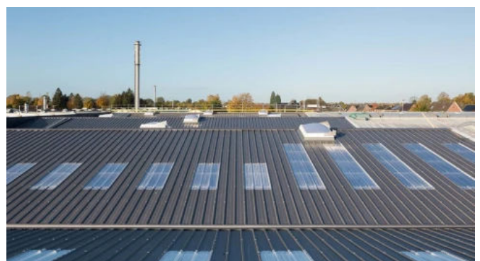
Dachsanierung einer Lagerhalle in Bocholt KS RW
