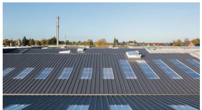
Dachsanierung einer Lagerhalle in Bocholt KS RW
