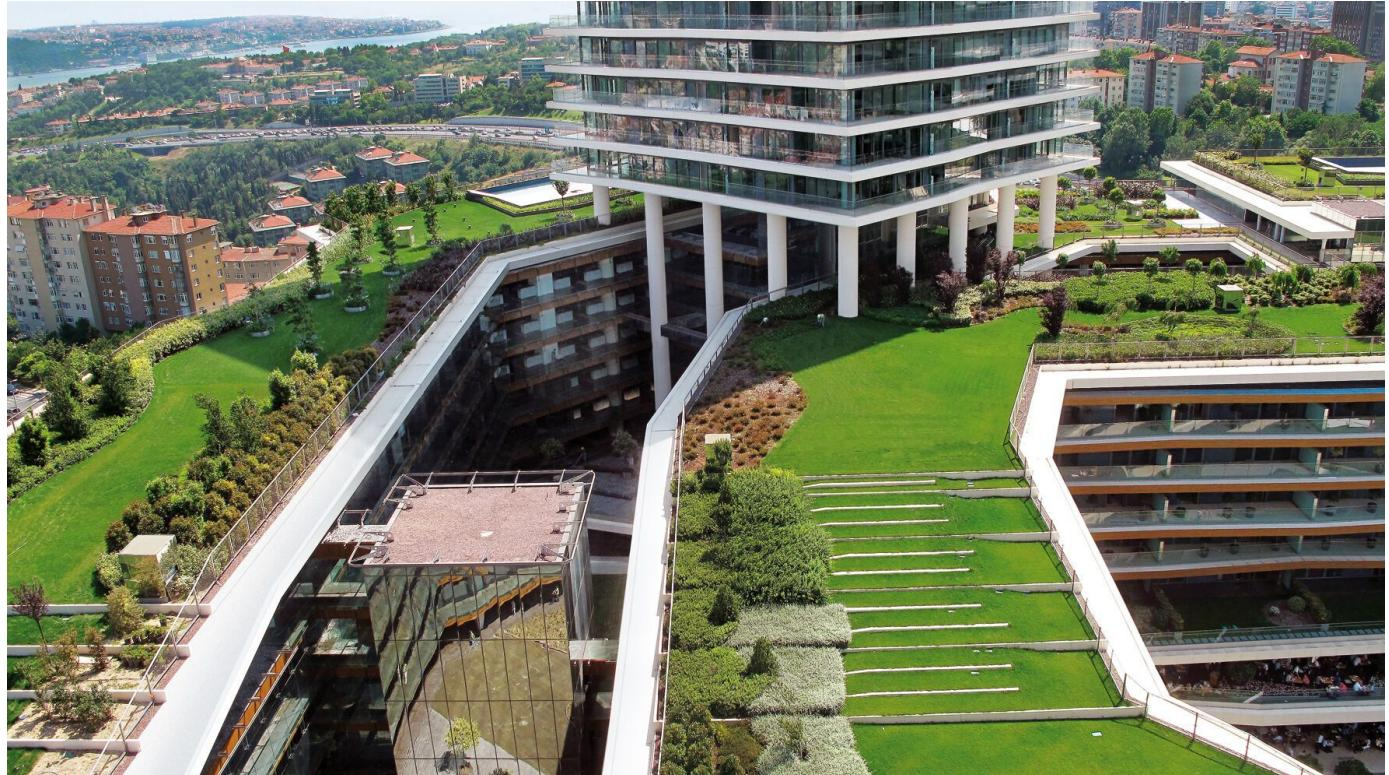
Eine intensive Dachbegrünung lässt sich mit dem Aufbau eines Gartens auf einem Dach vergleichen.
