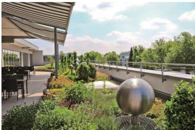
Mit dem Gründachaufbau „Dachgarten“ lässt sich nahezu alles realisieren, was auch zu ebener Erde möglich ist. Es handelt es sich um einen multifunktionalen Systemaufbau mit hoher Wasserspeicherung. Dadurch eignet er sich für Rasen, Stauden und bei höherer Substratschüttung auch für Sträucher und Bäume. Kombinationen mit anderen Nutzungsformen, z. B. Gehbelägen, Terrassenflächen, Fahrbelägen oder Spielbereichen, sind auf dem Gründach möglich.
