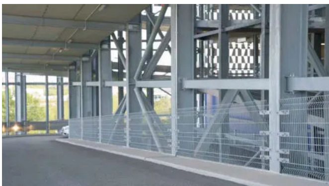
INTEGRA-pw 3.5 – Parkhaus Möbelhaus
