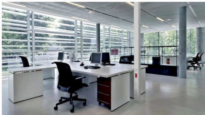
Boden-Decken-Installationssäulen sind frei sich im Raum positionierbar. Ein flexibler Schlauch zur Decke speist die Säule mit Daten- und Stromkabeln.
