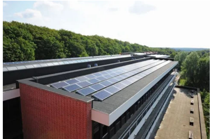
Die Unterkonstruktionen ermöglichen dank ihrer Süd-Ausrichtung von 15 Grad für hohe Erträge während der Mittagsstunden.
