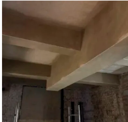
Kastenförmige Bekleidung von Deckenträgern
