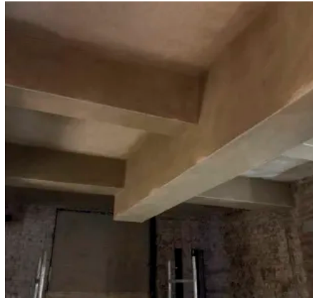
Kastenförmige Bekleidung von Deckenträgern
