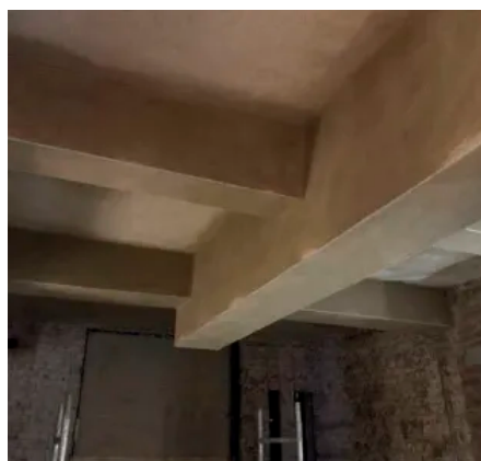
Kastenförmige Bekleidung von Deckenträgern
