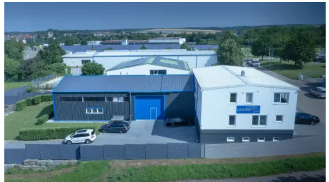
Lager- und Logistikhalle - Modulare Raumlösungen
