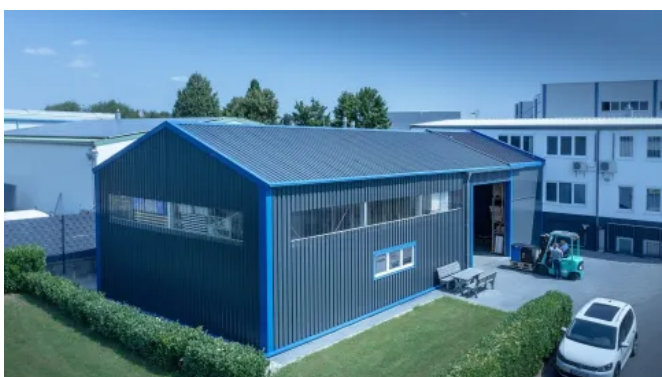
Lager- und Logistikhalle - Modulare Raumlösungen
