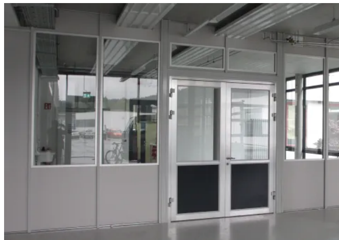
Trennwände im Eingangsbereich
