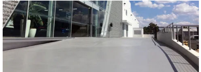
Vulkem Quick Systeme auf Gehwegen
