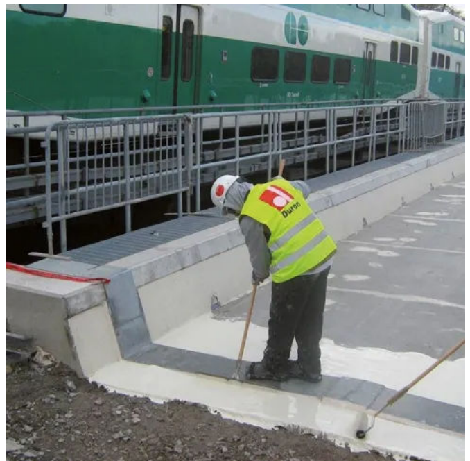
PUMA-Systeme ermöglichen eine besonders feste Verbindung aufeinanderliegender Schichten
