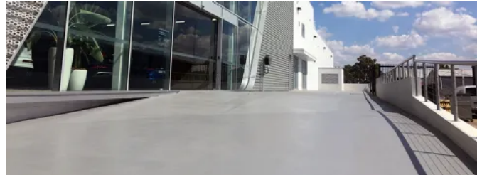
Vulkem Quick Systeme auf Gehwegen
